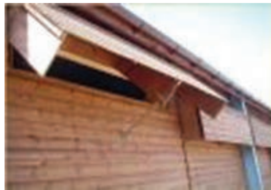
تصویر ۱۴-۲ - انواع دریچه‌های ورود هوا
