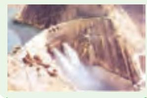
شکل ۱۰—انرژی پتانسیل گرانشی آب به انرژی چنشی توربین تبدیل می‌شود؛ سپس انرژی چنشی توربین در ژنراتور به انرژی الکتریکی یا مuman برق تبدیل می‌شود.
