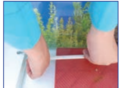
ت - نصب تجهیزات
