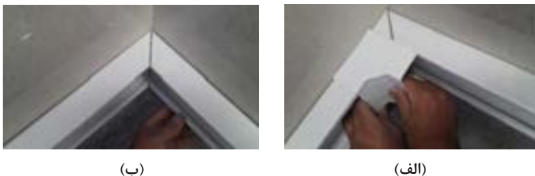
شکل ۴-۲۳- اتصال فارسی بر شده با زاویه ۴۵ درجه و تشکیل زاویه ۹۰ درجه
