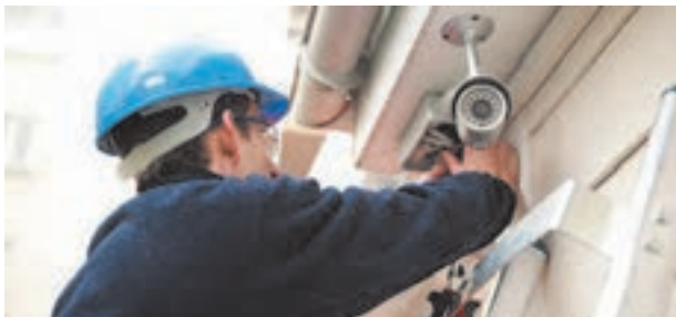
شکل ۲۹ - نصب دوربین در فضای مناسب
