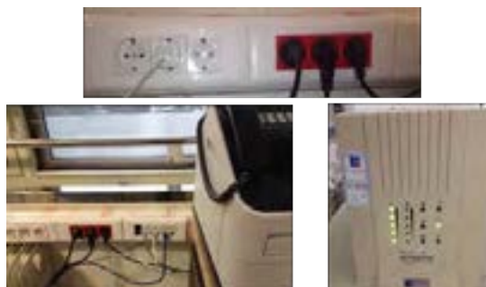
شکل ۱۶ - اتصال چند بار مختلف به UPS
