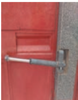
شکل ۲۱- جک هیدرولیک با فشار روغن
