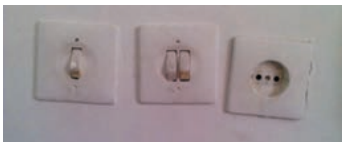
شکل ۵-۱- نصب غلط کلید و پریز
