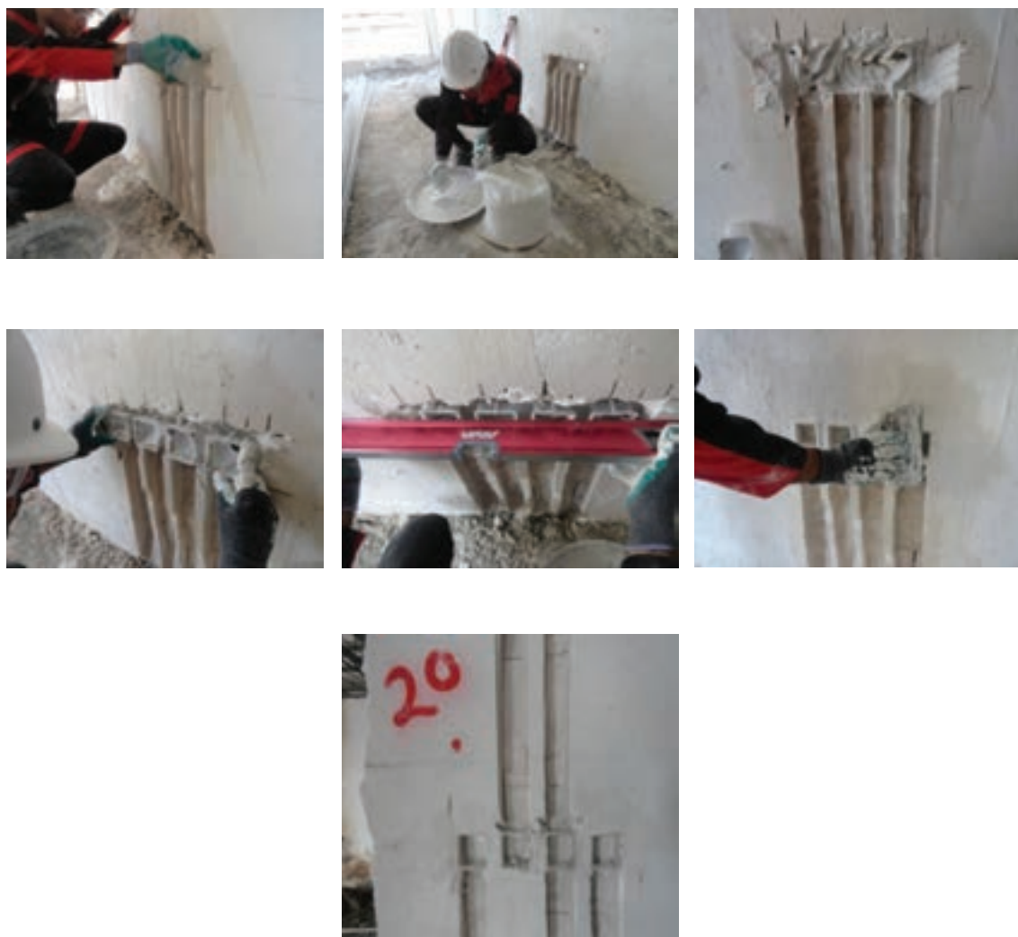
شکل ۳۷-۲- مراحل نصب قوطی کلید و پریز
