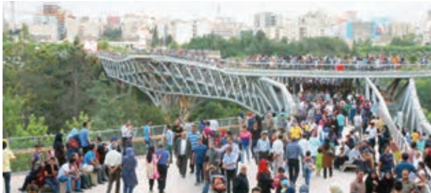
پل طبیعت - تهران
