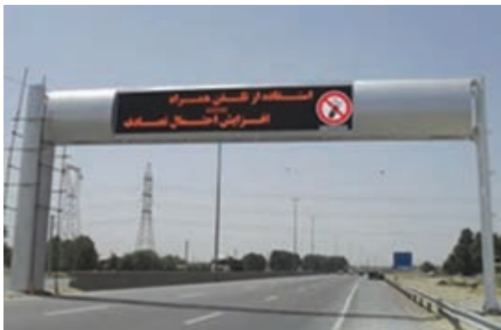
شکل ۱۴-۵- نمایش از تابلوهای پیام متغیر
