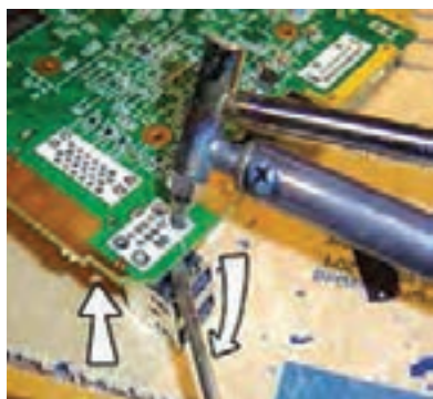
شکل ۸۷-۱- استفاده از قلع کش حرارتی
