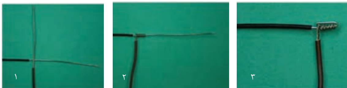
شکل ۵۲-۱- اتصال سیم افشان به سیم مفتولی
