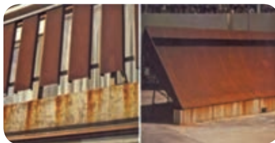
سطح زنگ‌زده ورق‌های آهنی در اثر قرار گرفتن در
