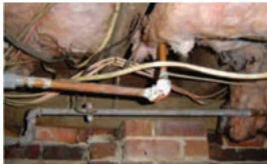
خوردگی زانوی فولادی گالوانیزه در اتصال با لوله مسی
