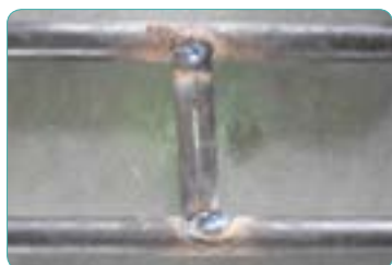
شکل ۴-۱۷ ثابت کردن لوله فلزی
