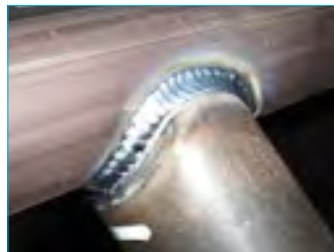
شکل ۶۰-۳ انشعاب گیری به روش سوراخ کردن لوله
