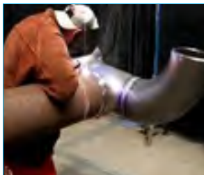
شکل ۶۱-۳ انشعاب گیری با استفاده از اتصالات جوشی
