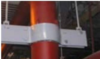
شکل ۱۸-۲ تکیه‌گاه لوله قائم
