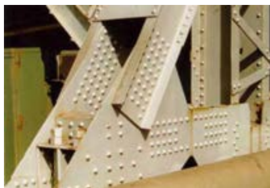
شکل ۱۸-۳ سازه فلزی اتصال پرچی (الف)
