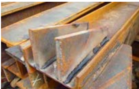
ب) شکل ۳-۱۹ اتصال سازه فلزی جوش کاری
