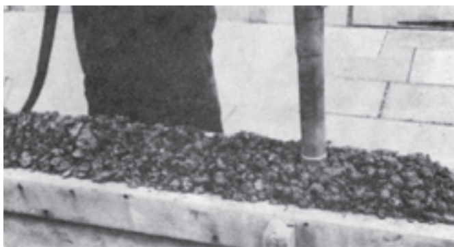
شکل ۱۲-۶- فرو بردن یک لرزاننده میله‌ای در داخل بتن تازه در یک قالب تیر
