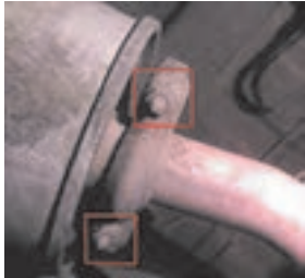
کنترل اتصالات لوله از صدا خفه کن
