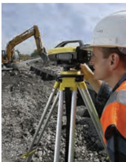
شکل ۱-۱۴ - اجرای تسطیح و کنترل حین اجرا
