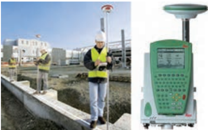
شکل ۷-۶ - پیاده کردن نقاط با GPS و PDA
