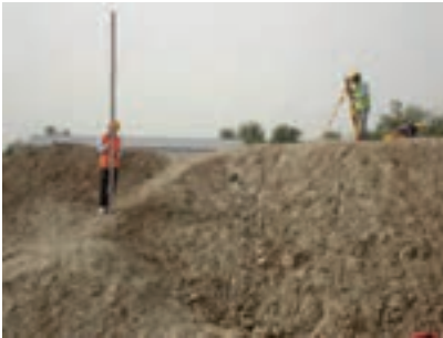
▲ شکل ۱-۶ برداشت به روش تاکنومتری با دوربین ترازباب دیجیتال
