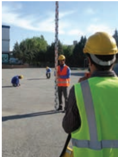
► شکل ۱-۴- عملیات پروفیل برداری از مسیر
