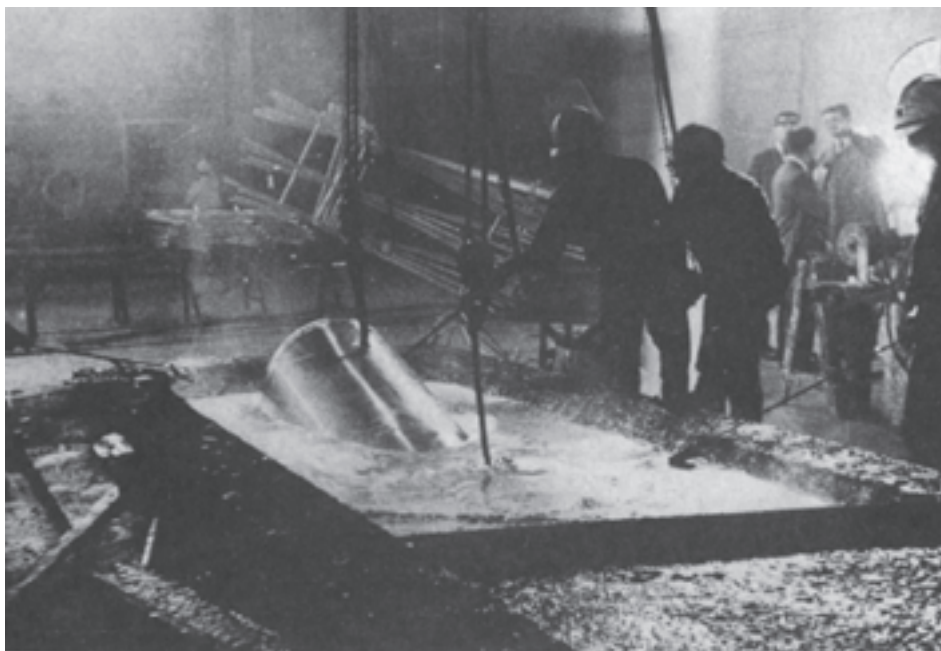
شکل ۷-۱۲- تهیه آهن گالوانیزه که با فروبردن آهن در فلز روی مذاب به دست می‌آید.
