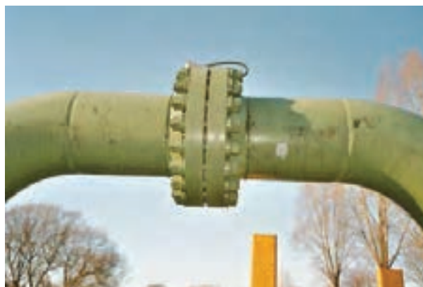
شکل ۱-۲ اتصال با فلنج
