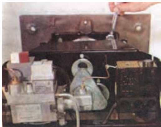
شکل ۳-۲- نصب مشعل روی دیگ
