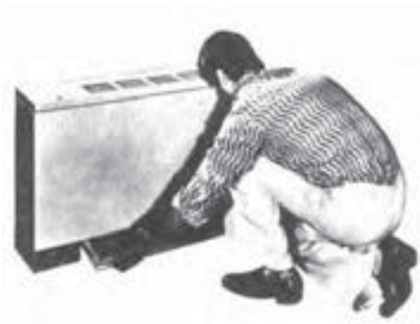
شکل ۹-۵- درآوردن فیلتر فن کویل
