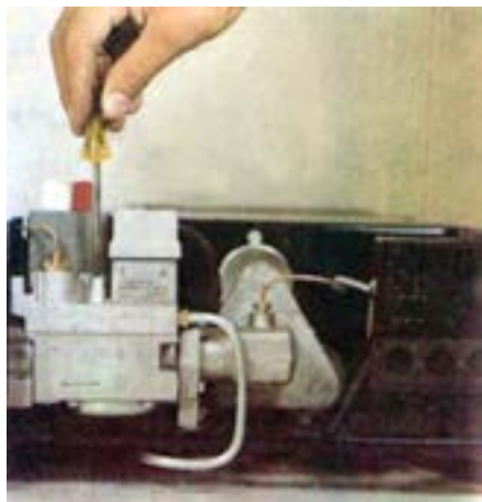
شکل ۳۲-۵ - تنظیم شعله پیلوت
