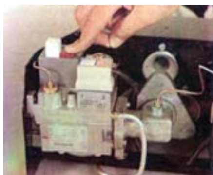
شکل ۳۴- ۵- خاموش کردن دائم مشعل
