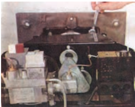
شکل ۳۰-۲ نصب مشعل روی دیگ
