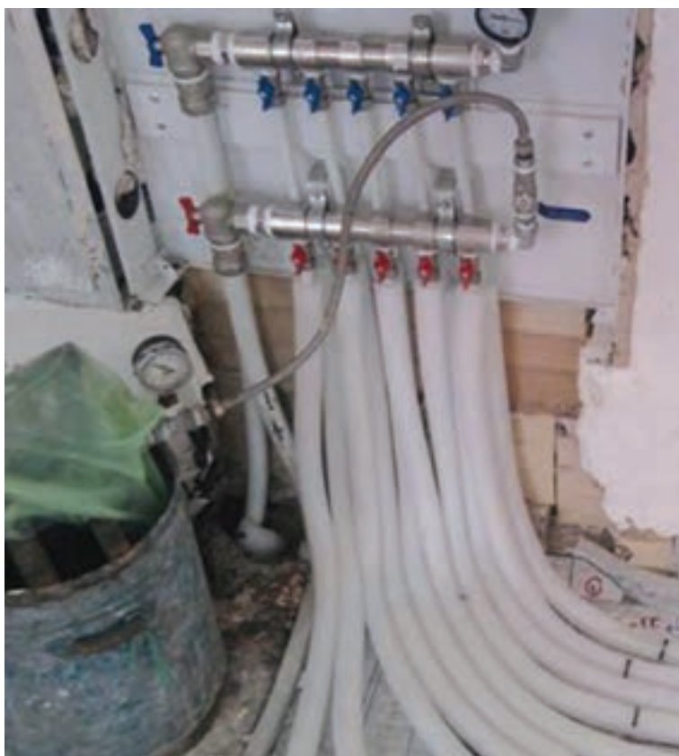
شکل ۲۰-۳- آزمایش آب‌بندی لوله‌کشی
