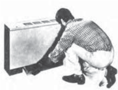
شکل ۹-۵- درآوردن فیلتر فن کویل
