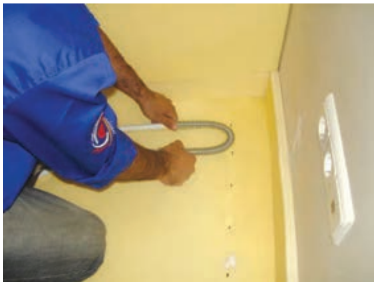
شکل ۳-۱۷- چگونگی خم کردن لوله
