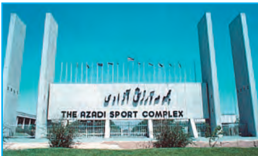
شکل ۵-۱- در ورودی - خروجی غربی مجموعه ورزشی آزادی تهران
