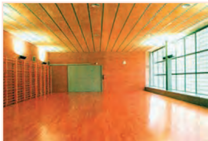
شکل ۴-۵- برای ورود و خروج این سالن از در ریلی استفاده شده است.
