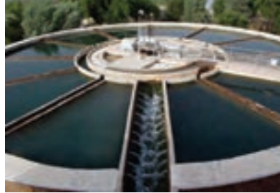
آب در تصفیه‌خانه
