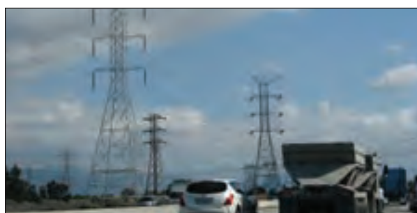
▲ شکل ۱-۵- انتقال انرژی الکتریکی توسط دکل‌ها
