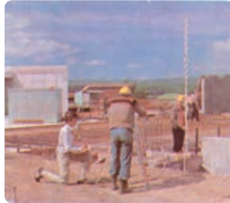
شکل ۱۴-۸- طریقه‌ی نگاه داشتن میر
