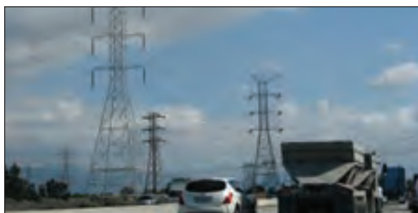
▲ شکل ۱-۵- انتقال انرژی الکتریکی توسط دکل‌ها
