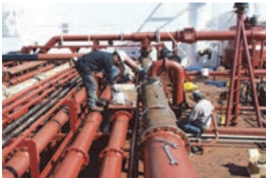
شکل ۷- در حال اجرای لوله‌کشی کشتی
