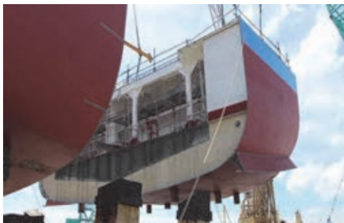
شکل ۸- اتصال بلوک‌های کشتی
