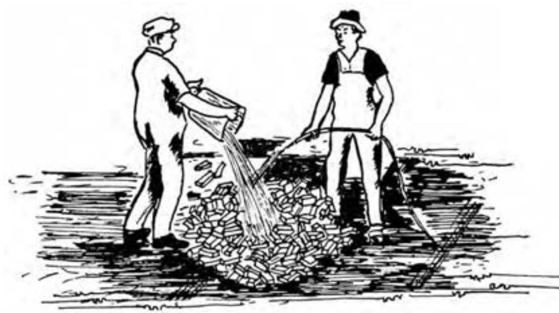
شکل ۳-۳۷ ▲ زنجاب کردن آجر
