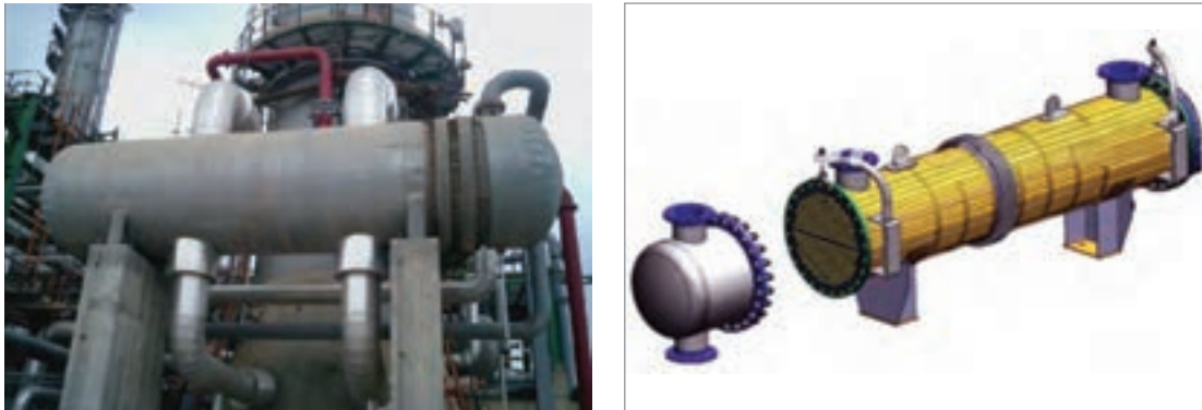
شکل ۲۹- مبدل حرارتی پوسته و لوله (نماهای بیرونی و داخلی)
