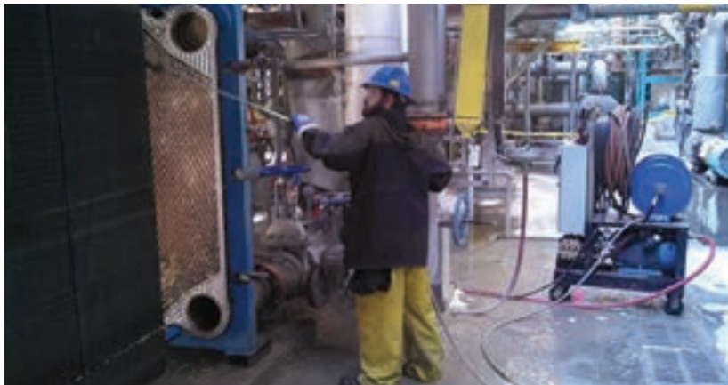
شکل ۱۴ - روش فشار آب (جت آب)
