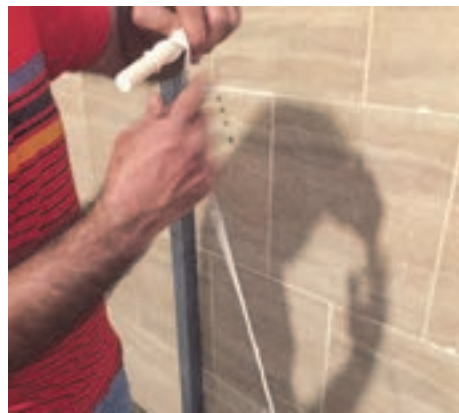
شکل ۶۷- پیچیدن نخ ها روی چوب ماسوره
