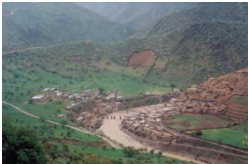
شکل ۳۸-۱- عدم رعایت حریم رودخانه و خطر سیل
