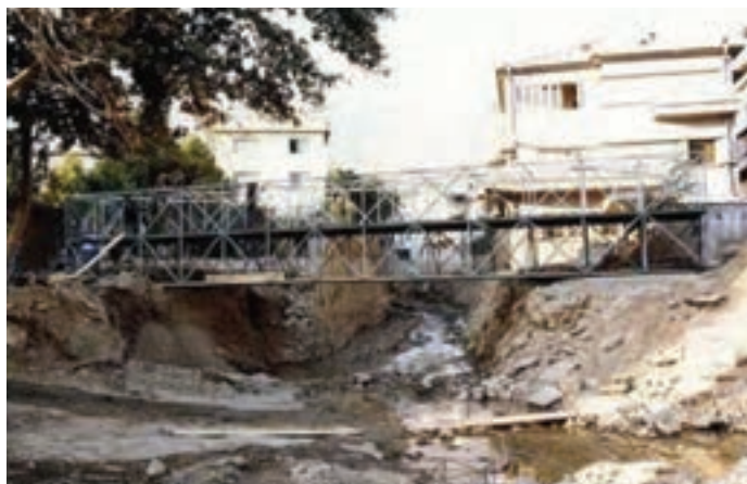
شکل ۲۴-۱- تخریب ساختمان‌ها و مسیر رود تجریش بر اثر سیلاب گلابدره تهران، مرداد ماه ۱۳۶۶
