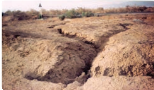
شکل ۱-۵۴- پدیده فرونشست در منطقه رضوان شهر
