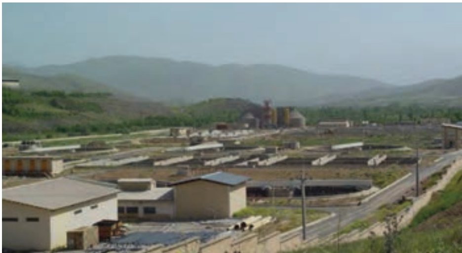
شکل ۷۳-۱- تصفیه‌خانه فاضلاب سنندج
