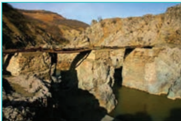
شکل ۲۷-۵- پل قالاتاسیان سردشت
