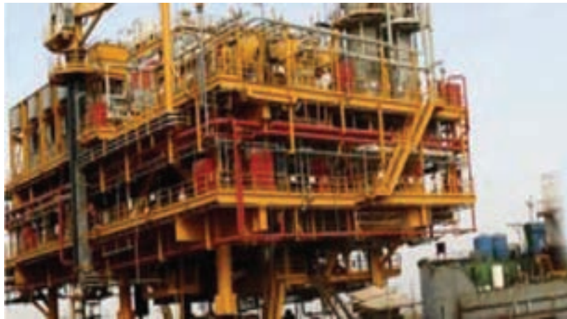
شکل ۳۷-۵- ساخت سازه و سکوهای دریایی در خرمشهر
