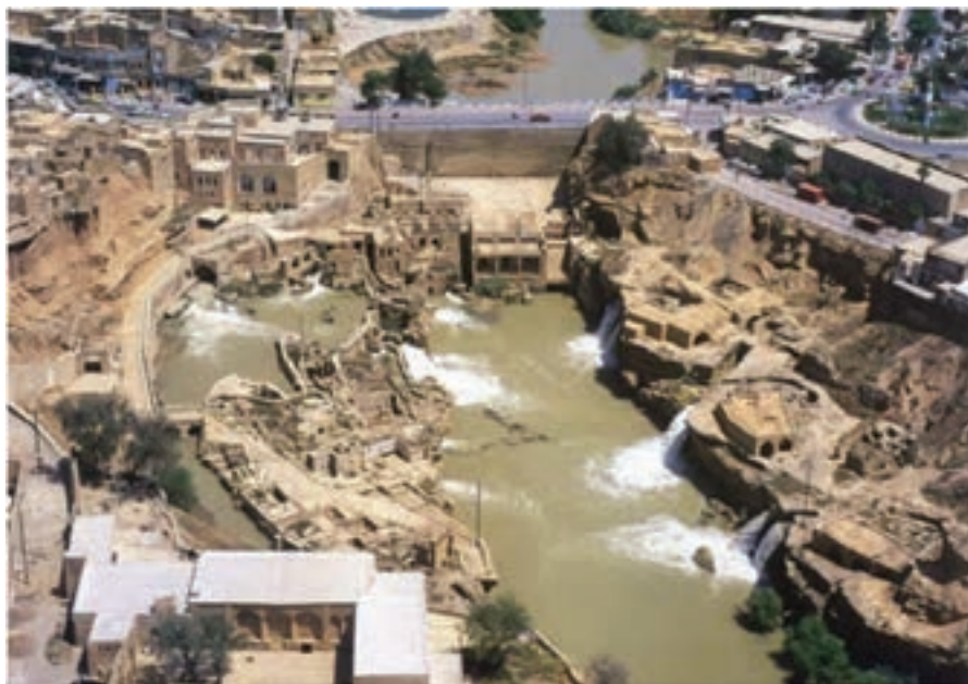
شکل ۱۴-۵- سازه‌های آبی شوستر
