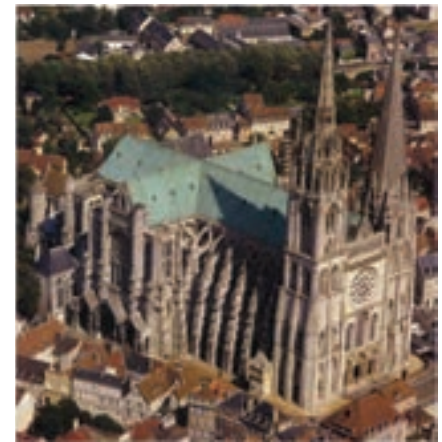
۳-۴۰ چشم انداز هوایی شمال غربی کلیسای جامع شارتر، فرانسه، شروع ساخت ۱۱۳۴، بازسازی ۱۱۹۴ میلادی
