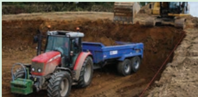
شکل ۴-۲۱- بارگیری نامناسب پی نورد
