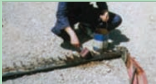
شکل ۵۰- تمیز کردن شانه برش با گازوئیل
