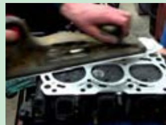
شکل ۶۶. تمیز کردن سطح بلوکه سیلندر با سنباده زن دستی و الکتریکی
