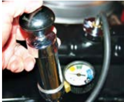
شکل ۶. آزمایش نشت یابی تحت فشار
