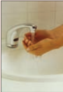
شکل ۱۳-۷- شیر اتوماتیک چشمی ▲
