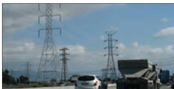
▲ شکل ۱-۵- انتقال انرژی الکتریکی توسط دکل‌ها
