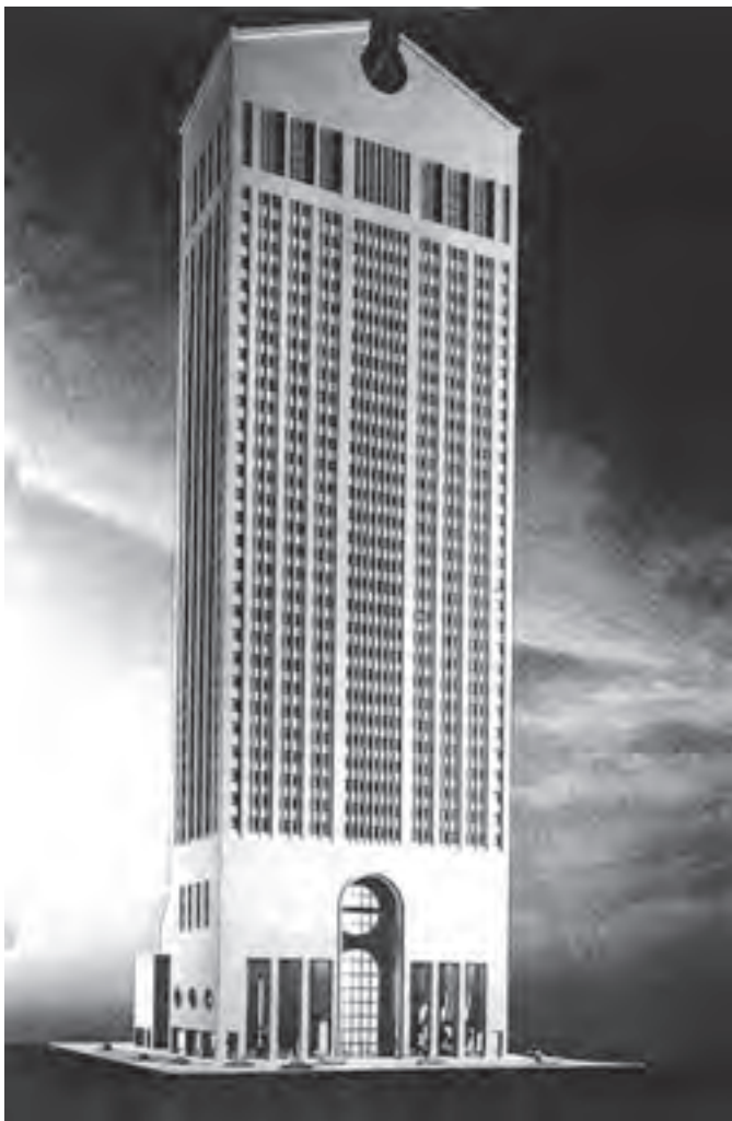
تصویر ۱۶- معماری پست مدرن، ساختمان سونی، اثر فیلیپ جانسون ۱۹۸۳، نیویورک (یادآور کمد قدیمی)
