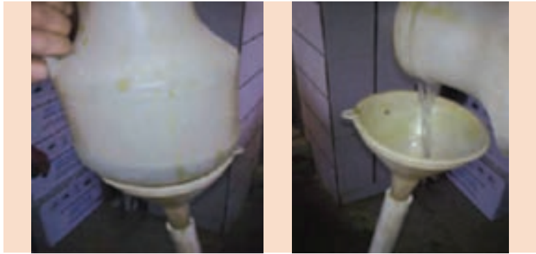
ریختن اسید داخل مبدل جهت رسوب‌زدایی
