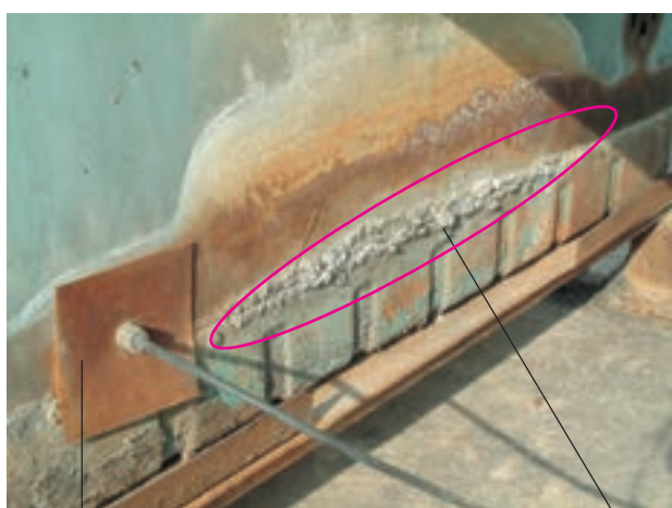
رسوب‌های آب تعمیر غیراساسی شکل ۸-۱۷۶
