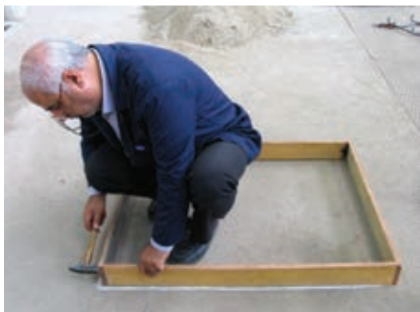
شکل ۴-۱- قالب بندی فونداسیون
